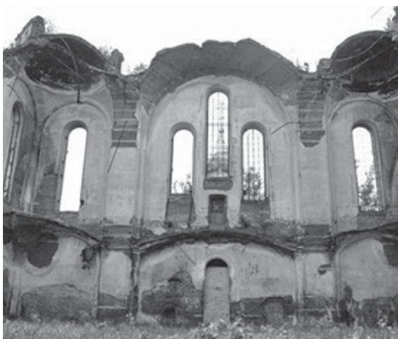
Разрушенный Троицкий собор
